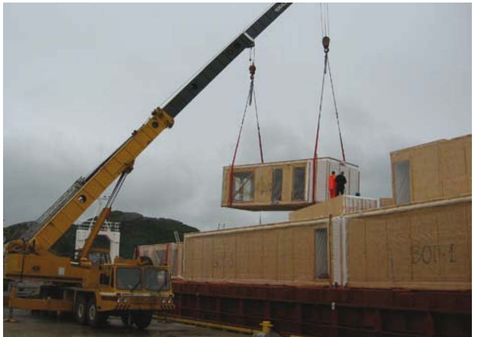
Ruumelementide mahalaadimine laevast.
